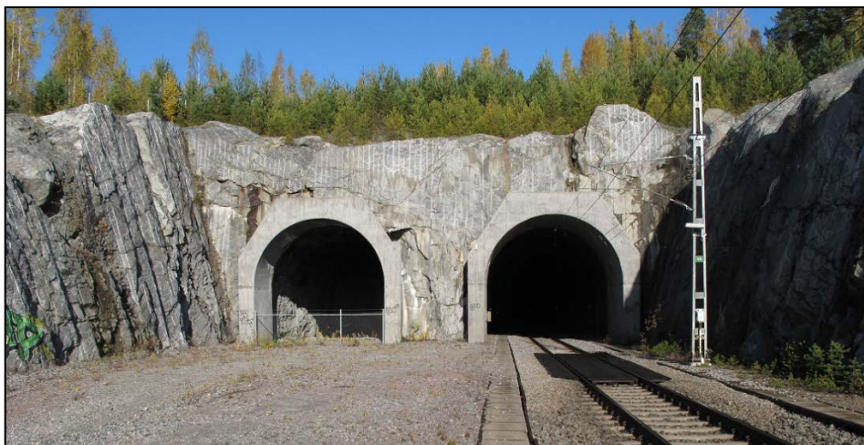
Bild 2. Förberedelse för dubbelspår för tunneln Hällåsen södra på Ostkustbanan.
