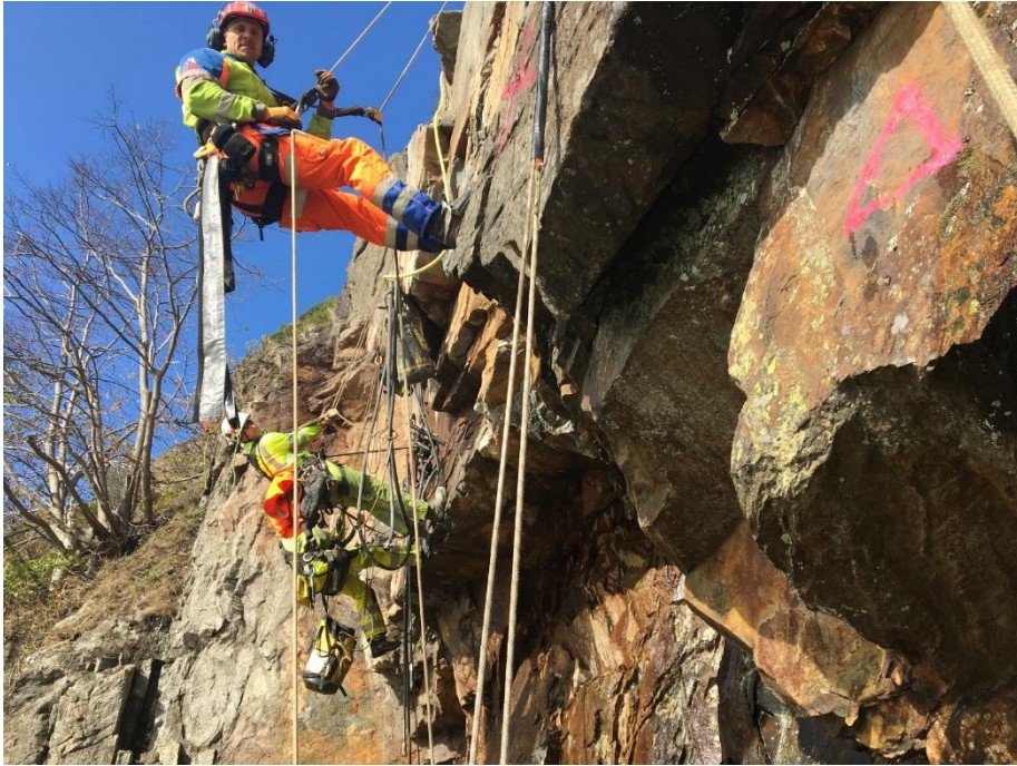
Figur 2. Pågående bergrensning från rep.
